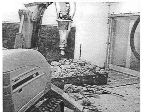
図2 パワーシャベルによるコンクリート 構造物の破碎
