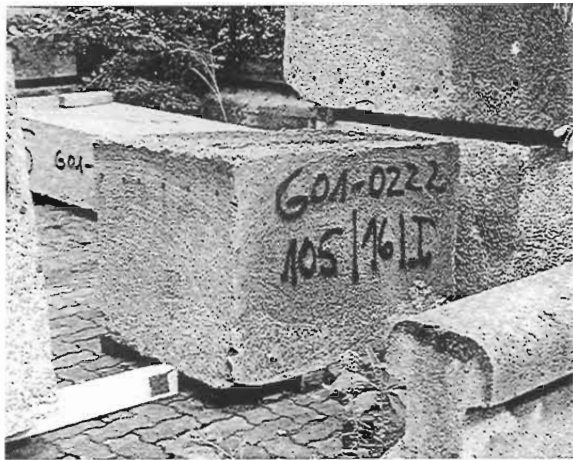
図1 ブラスト除染の終了したコンクリート 構造物
